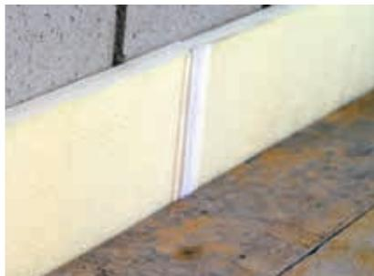
Randstellstreifen **ISOPE** im Bereich der Fuge zwischen Treppenpodest und Wand. Die Verbindung der Stossfugen erfolgt mittels baustellentauglichem Klettverschluss oder alternativ mit Klebeband.
