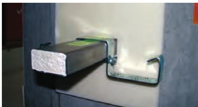
Körperschallbrücken sind unbedingt zu vermeiden! **ELKRAG-E mit präzisiertem Ausschnitt** im Bereich der Dorndurchdringung sichert eine fehlerfreie, saubere Ausführung dieses wichtigen Details.
