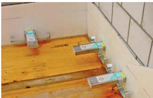
**Bauweise Ortbeton:** Fertig eingebaute ISOLA®-35-45-OB mit Dorn-330-X im Podestbereich. Akustische Trennung zur Wand mittels geschlossenzelligem, baustellentauglichem Weichschaumstoff ISOPE-20.
