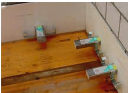
Montierte **Randstellstreifen ISOPE-20**. Die Treppenabwicklung ist direkt auf dem ISOPE aufgerissen und die Tritte werden danach massgenau abgeschalt.
