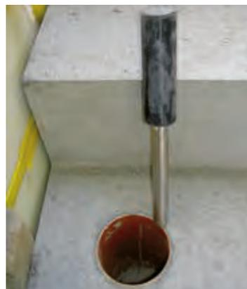
Der körperschalldämmende Sicherungsorn ISODORN wird durch die Rohr-Aussparung in das Bohrloch in der Decke eingeführt. Danach wird die Aussparung mit Vergussmörtel geschlossen.
