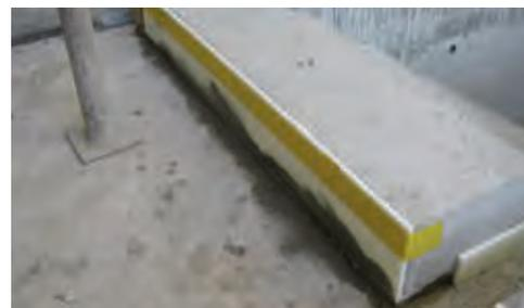
Versetzte Treppen-Elemente. Die Fuge der Auflagerabwicklung zwischen Podest und Treppenlager ISOTREPP® ist mit Mörtel sauber ausgegossen.
