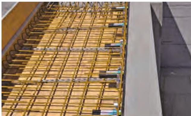
**Bauweise Ortbeton:** Armierte Betonplatte mit eingebauten Podestlagern Typ ISOMODUL-28-45-OB mit Dorn-330-S und Armierungsbügel zur sicheren Kräfteinleitung.
