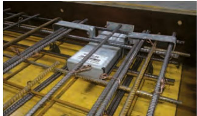
**Bauweise Beton-Elemente:** ELBOX-60 mit Armierungsbügel, montiert an der Abschalung des vorgefertigten Podest-Elementes. Vorgefertigte Elemente werden in der Regel in einer Negativ-Schalung betoniert. Daher ist die ELBOX mit Armierungsbügel um 180° "kopfstehtend" eingebaut.
