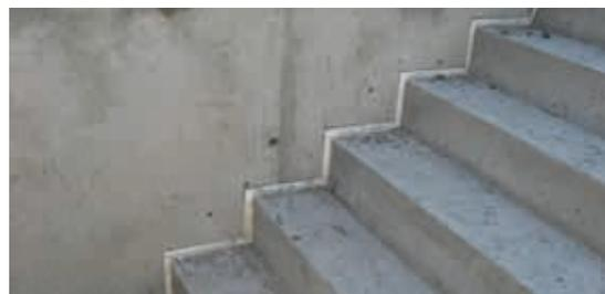
Fertig betonierte Treppe. Der **Randstellstreifen ISOPE** ist auf der ganzen Abwicklung sichtbar und wird erst beim Einbringen des Treppenbelages zurückgeschnitten.
