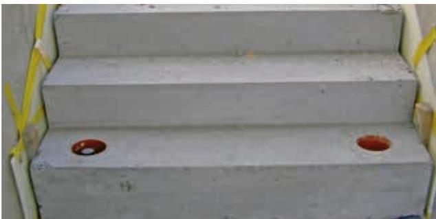
Versetztes Treppen-Element mit seitlicher ISOPE-Trennung zum Gebäude. Im Vordergrund die Rohreinlagen zur Montage der körperschalldämmenden Sicherungsorne ISODORN.
