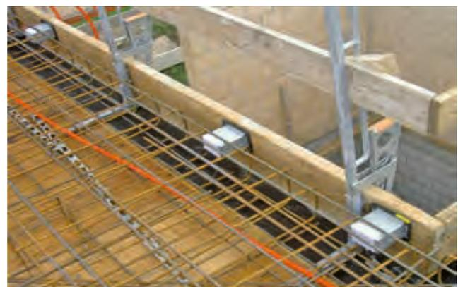
**Bauweise Ortbeton:** Die Schallschutzgehäuse ISOLA® 35 dB sind lagerichtig an der Ab Schalung zum Treppenhauskern montiert und werden in der Decke einbetont.
