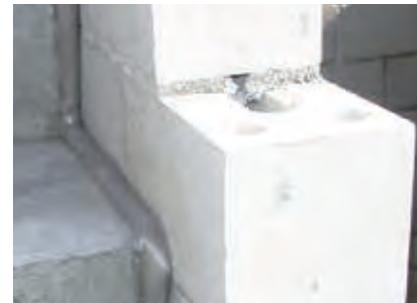
Auskleiden der Fuge mit **ISOSTRANG** nach Versetzen des Treppen-Elementes. Damit werden Körperschallbrücken in einem nachträglich nicht mehr kontrollierbaren Bereich von Bauteilfugen wirksam und kostengünstig vermieden.
