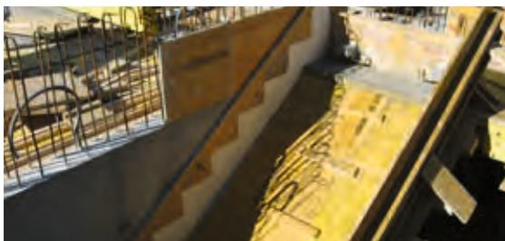
**Randstellstreifen ISOPE-20** im Bereich der Treppenwange. Beim Einpassen des ISOPE entlang der Treppenabwicklung wird das Mass für den Treppenbelag zugegeben.
